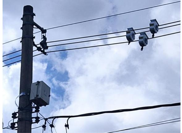
Detección de Eventos y Monitoreo y distribución de redes MT de 5,2 kV a 34,5 Kv AT hasta 69kV más de 63 puntos a monitorear entre análogos y digitales.
